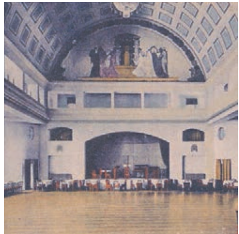
Der ehemalige Saal in der „Weltemühle“
