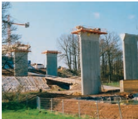
2000: Baumaßnahmen zur A17 bei Zöllmen
